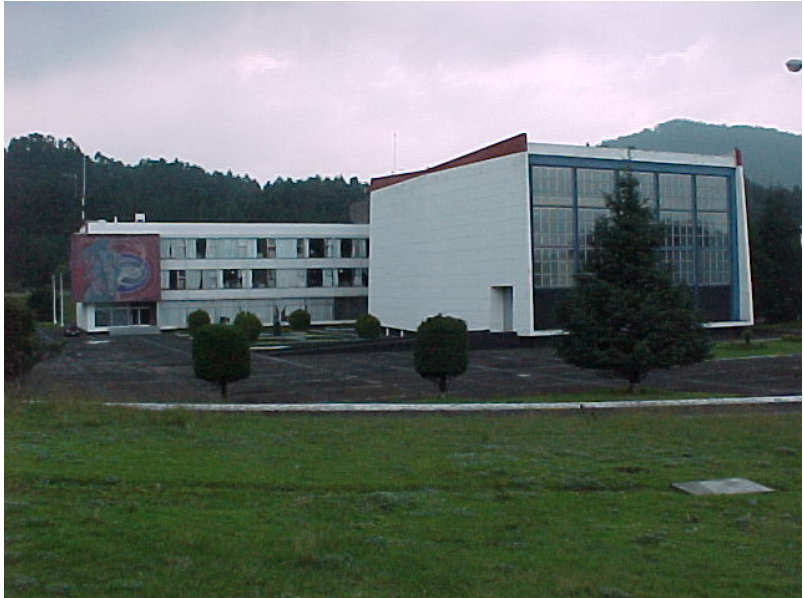
Figura 1. Vista frontal del edificio del reactor.
